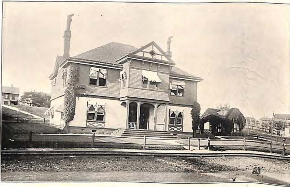
Dispatchers' Office, N. & W. R. R.
